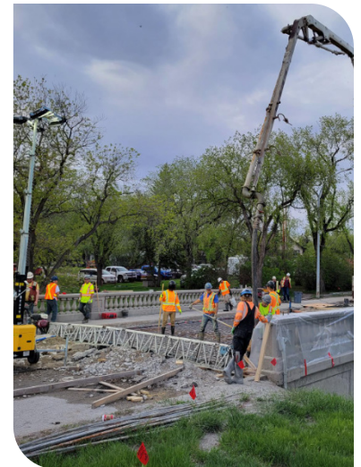
Spadina Crescent Bridge - Deck Pour
